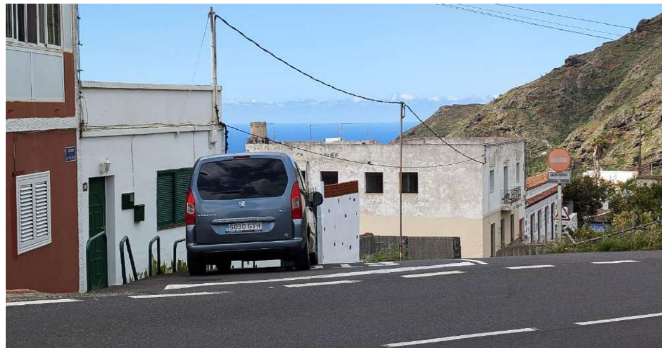
Figura 45. Estacionamiento de vehículo en cruce con baja visibilidad Fuente: Elaboración propia
