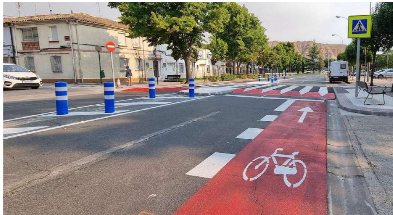
Figura 36. Ejemplo de aplicación de paso peatonal elevado Fuente: La Rioja
