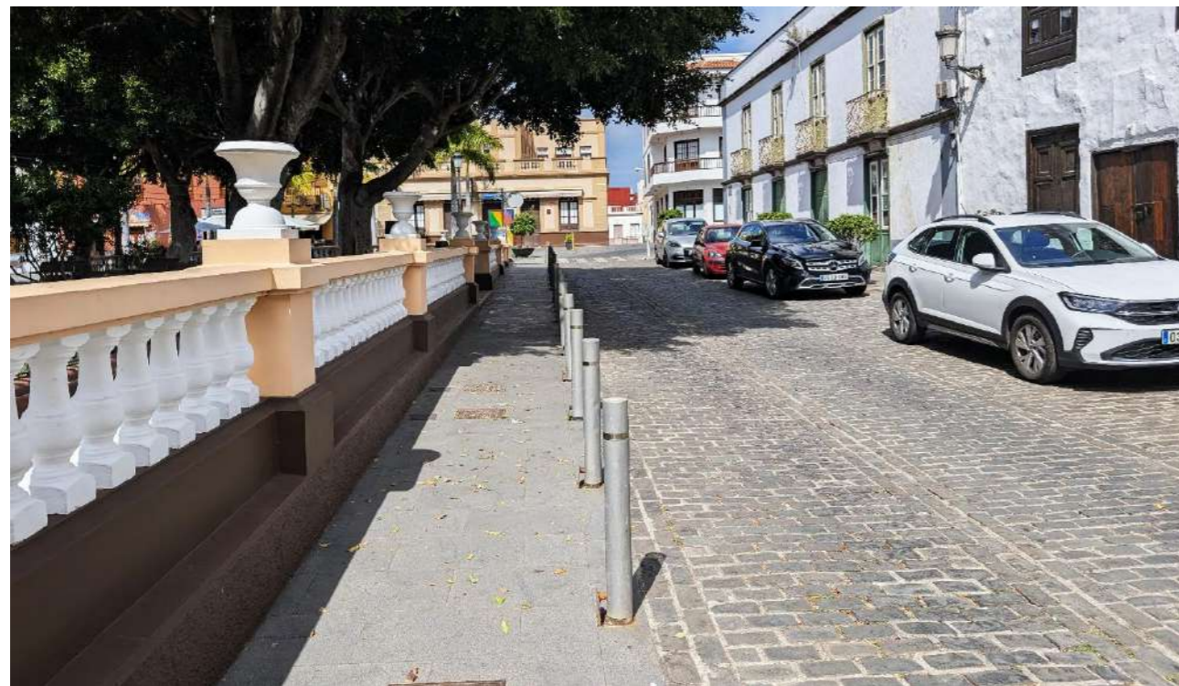
Figura 43. Elementos de balizamiento en Buenavista del Norte Fuente: Elaboración propia
