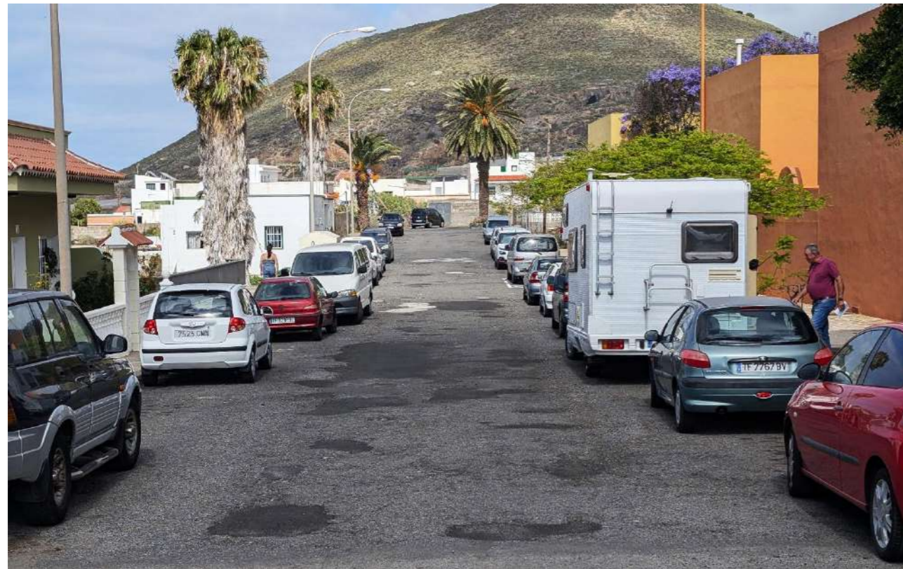
Figura 65. Ejemplo de vía con falta de mantenimiento en la C/Tiznado Fuente: Elaboración propia
