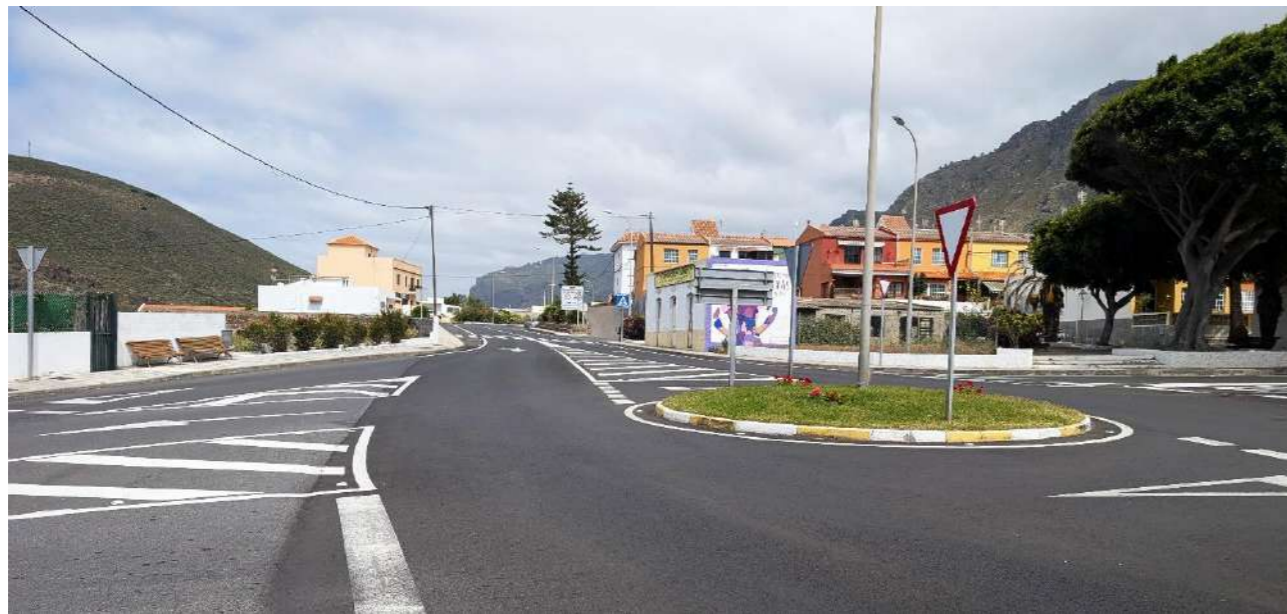
Figura 55. TF-42 en su acceso al casco de Buenavista del Norte Fuente: Elaboración propia
