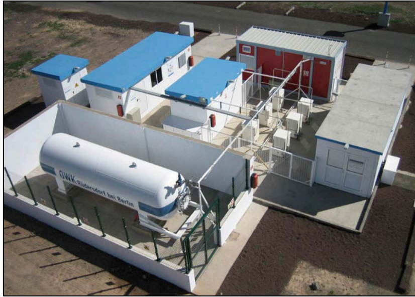
Ilustración 3. Distribución de la planta del proyecto RES2H2
