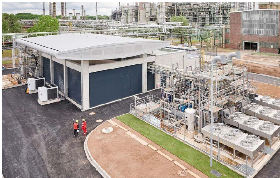
Ilustración 23. Electrolizador de 10 MW. Proyecto Refhyne
