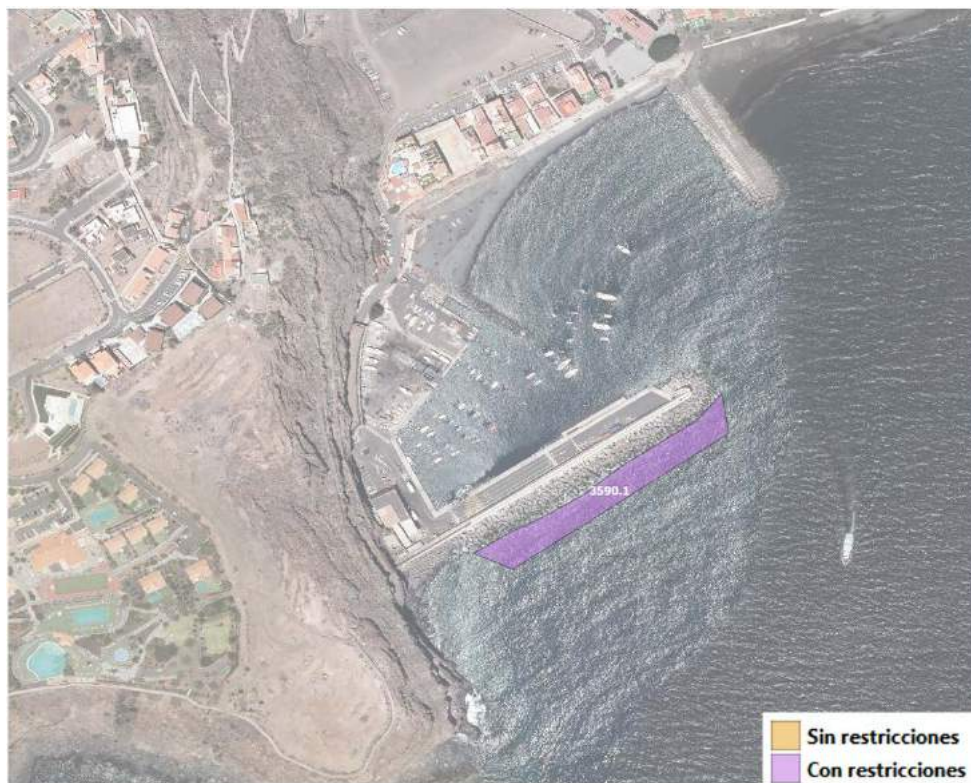
Figura 156 Zona habilitada en el Puerto de Playa Santiago
