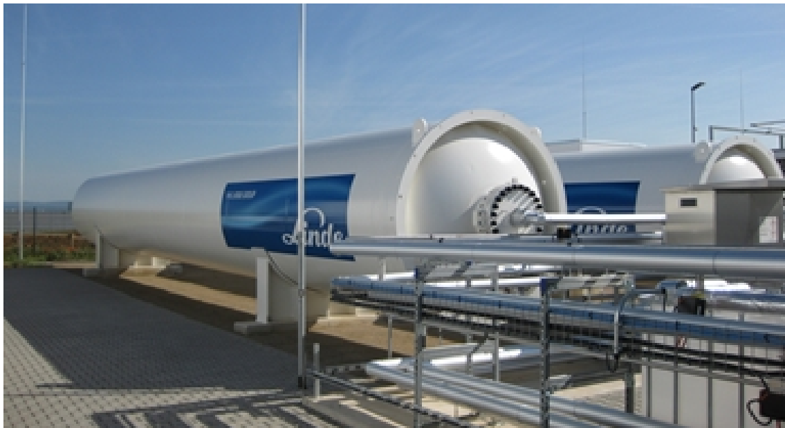
Ilustración 30. Ejemplo de tanque de hidrógeno a 350 bares
