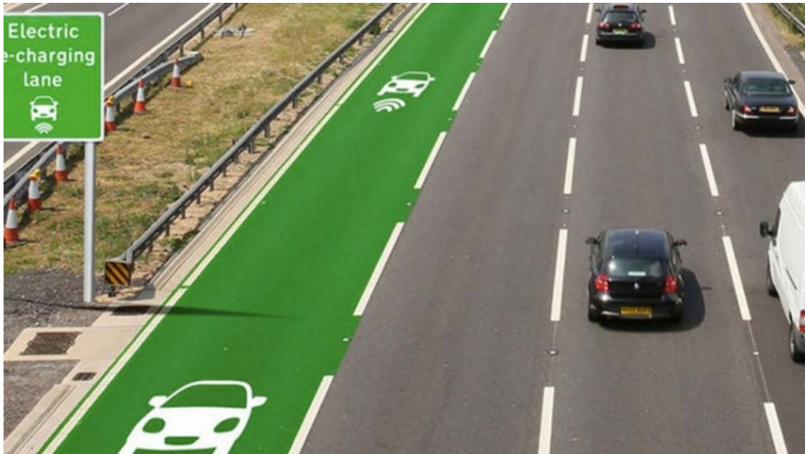
Figura 41 Autopista de recarga inductiva
