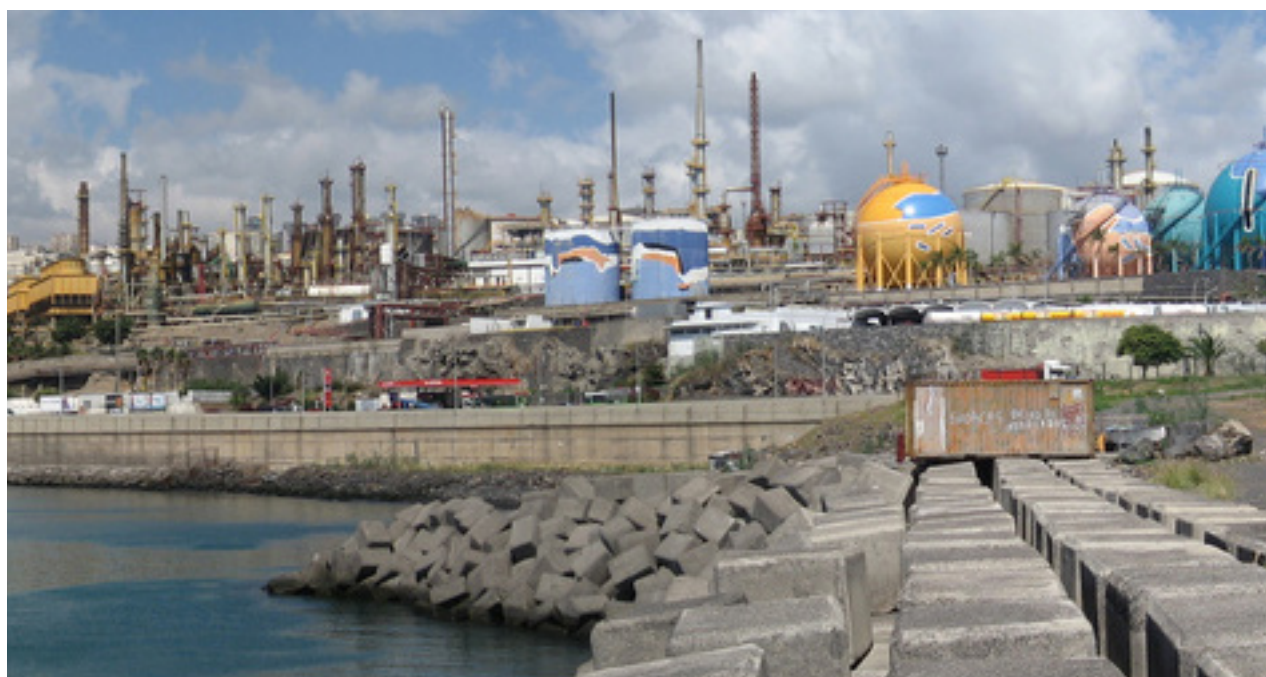
Imagen de la Refinería de petróleo de Tenerife. Foto: Mataparda
