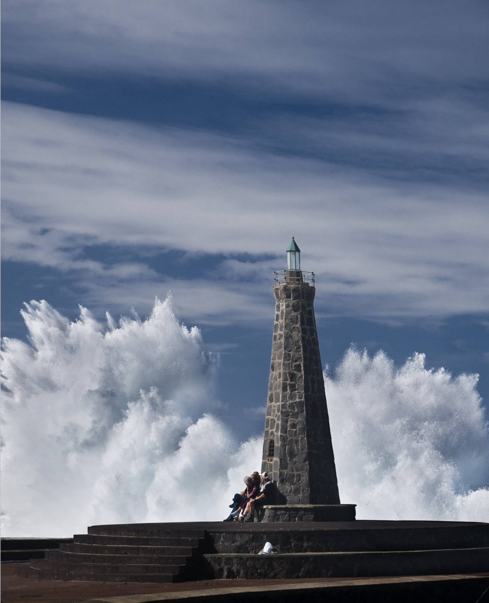
Arriba. Faro de Bajamar rompiendo la marejada en su trasera.
