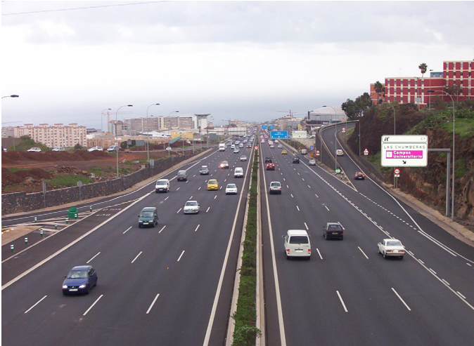
Vista de la Autopista TF5 a la altura del barrio de Las Chumbe- ras. Foto por FoxbaseAlpha.
